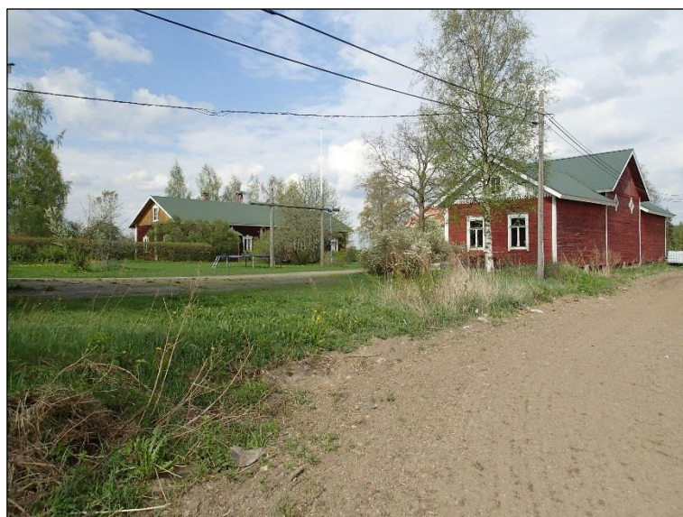
Pärrin tilan pihapiiriä. Kuva pohjoiseen.
